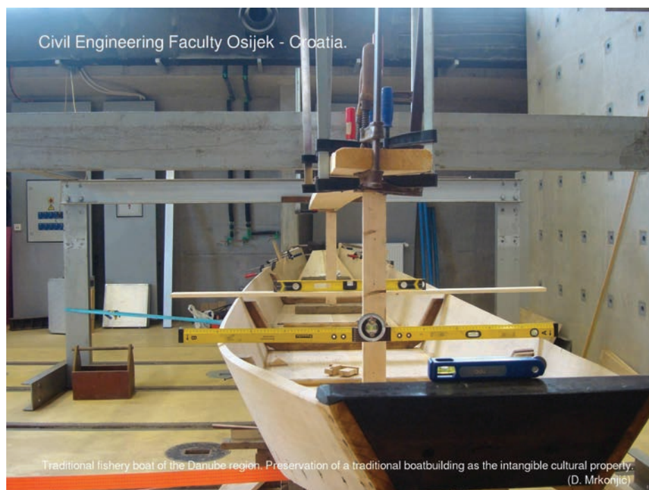
Slika 1: Gradnja čikla na Građevinskom i arhitektonskom fakultetu Osijek.
